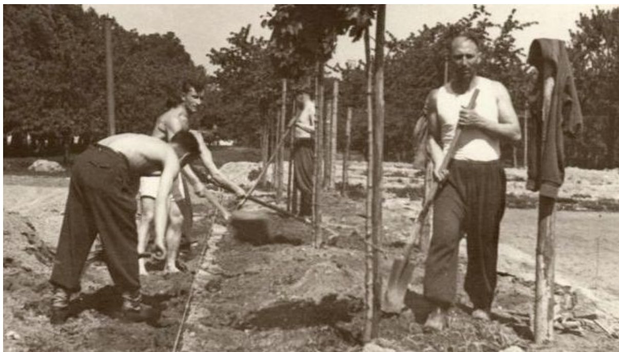
Antonín Mikan během stavby sportovního stadionu v Chraští. Zdroj: archiv pamětníka
